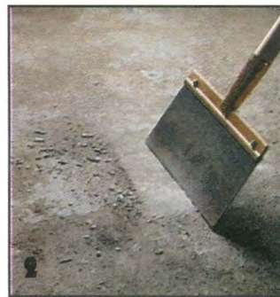
Старое лакокрасочное покрытие счищают широким скребком. Краску, прочно держащуюся на основе, можно оставить.
