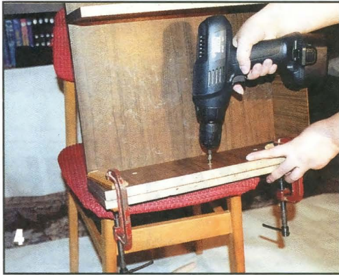
Боковые накладки — шире опор на 16 мм. Их прикрутили шурупами изнутри надстройки. За счет небольшого смещения накладок снизу они формируют с опорами четверть, а сверху выступают над полкой на такую же величину.
